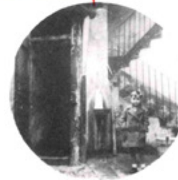
Servizi igienici insufficienti
