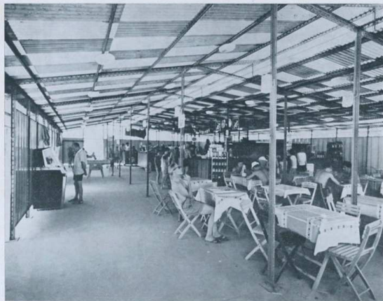
Campeggio prefabbricato smontabile per il C.N.A.S. a Jesolo
